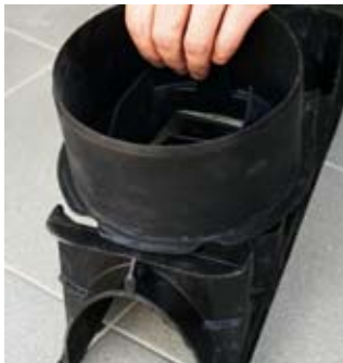
Nasazení přípojovacího adaptéru
