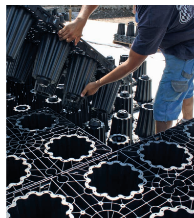
základní blok ACO Stormbrixx váží pouze 10 kg a umožňuje velmi snadnou instalaci
