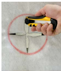
Před instalací základních prvků je nutné vyříznout na základních prvcích větrací otvory, příp. inspekční otvory pro větrací/inspekční potrubí.
