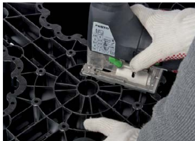
Před instalací základních prvků je nutné vyříznout na základních prvcích větrací otvory, příp. inspekční otvory pro větrací/inspekční potrubí.
