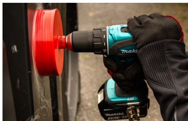
Vrtací korunkou vytvořte otvor u dna nádrže pro připojení regulovaného odtoku
