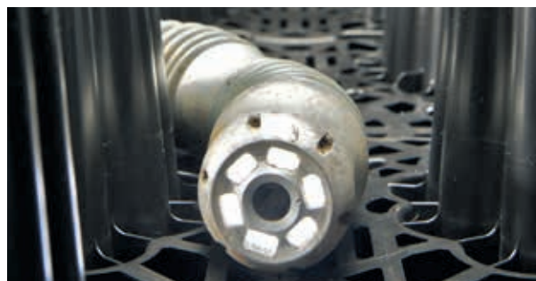
Schiebekamera, Reinigungsgerät mit Spülkopf
