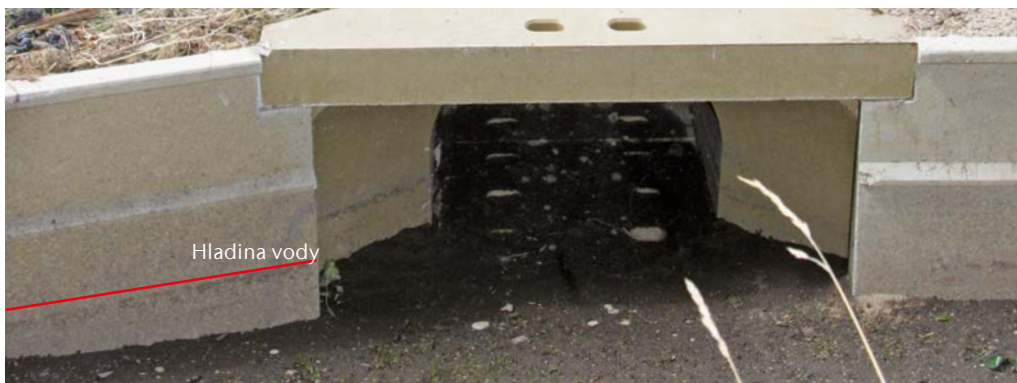
Desky ACO Climate plate s drenážní funkcí po silném dešti
