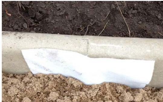
Geotextilie na zadní straně zábrany
