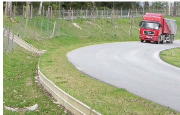
Výstavba u krajnice
